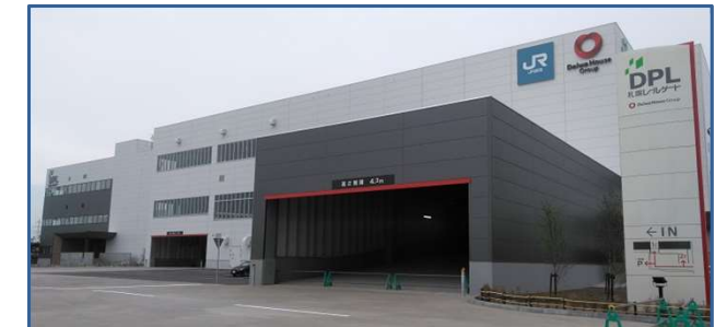
DPL札幌レールゲート
