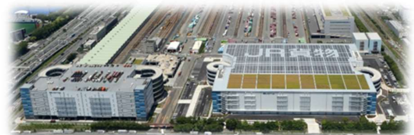
東京レールゲート
