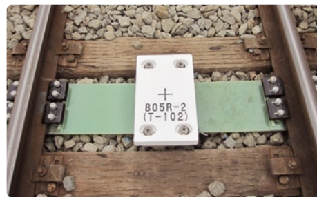
連続速度照査用のATS地上子
