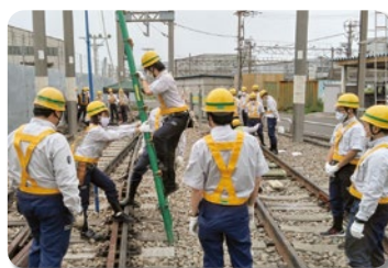
架線作業に関する実習
