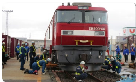
旅客会社との合同脱線復旧訓練
