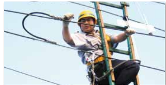
電車線部品交換実習
