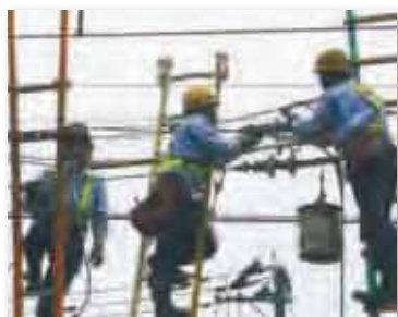
架線の碍子取替え作業
