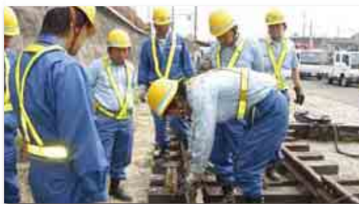
分岐器の組立実習
