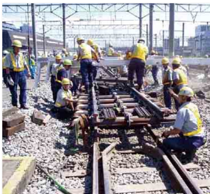
鉄まくらぎ分岐器交換作業
