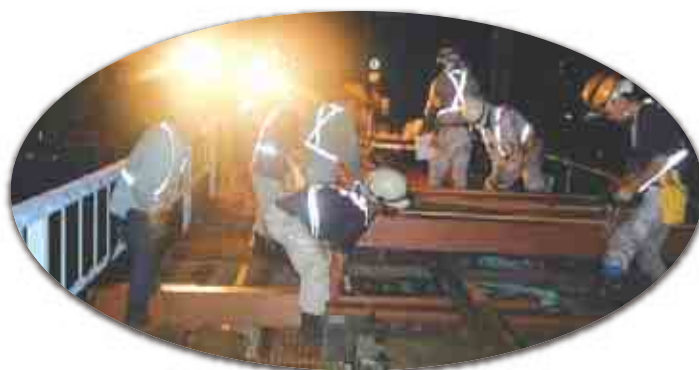
橋まくらぎの取替え作業
