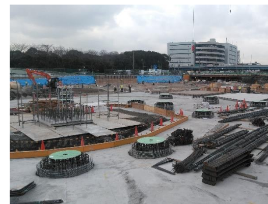
免震装置施工
