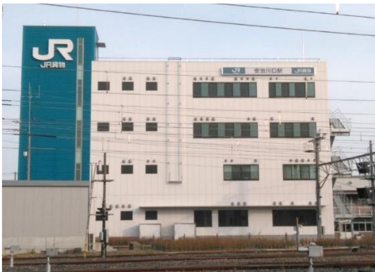
安治川口駅事務所 外観
