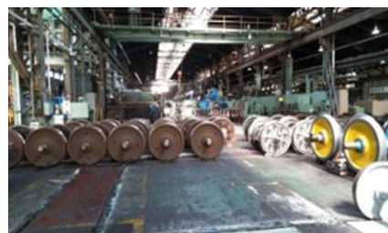
車両所の大規模改修
