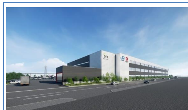
【DPL札幌レールゲート】
