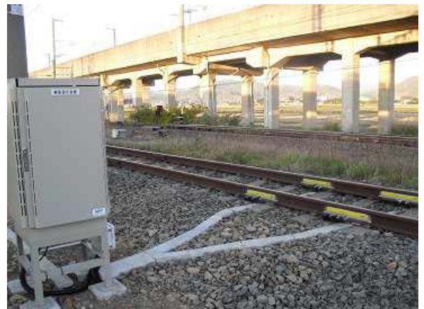
歪みゲージの設置完了
